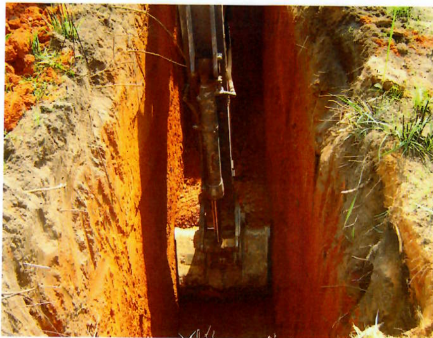
Figura 11 - Abertura de uma vala para determinação do perfil do terreno
