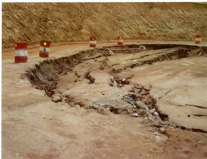
Figura 2 - Falhas numa bancada
