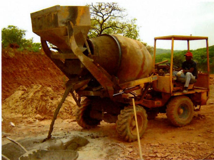
Figura 27 - Betoneira usada na fabricação de concreto
