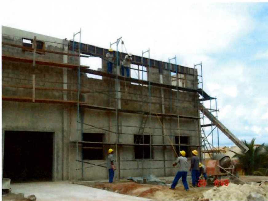
Figura 21 - Andaime usado na construção de um edifício
