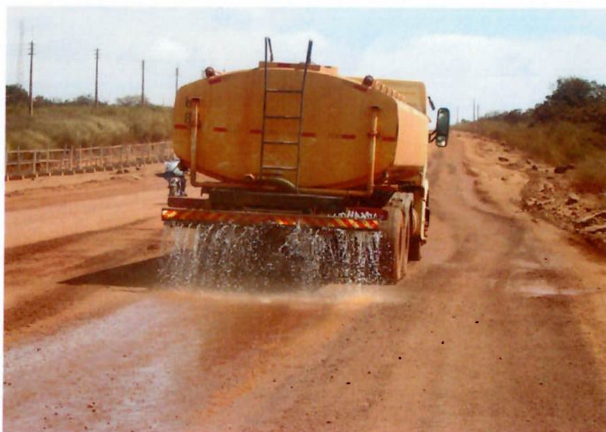
Figura 18 - Caminhão pipa em umectação das vias movimentadas da mina
