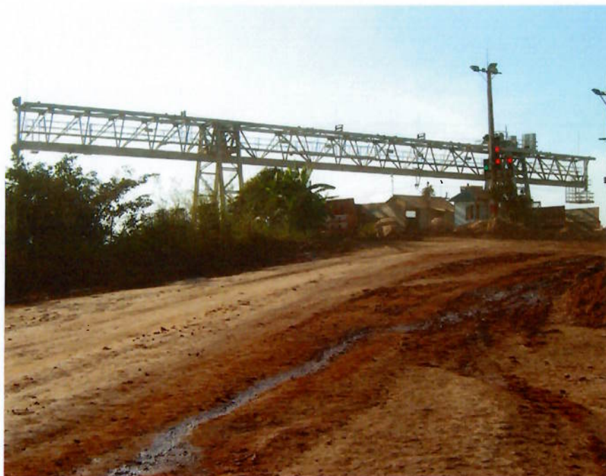
Figura 29 - Detalhes da grua
